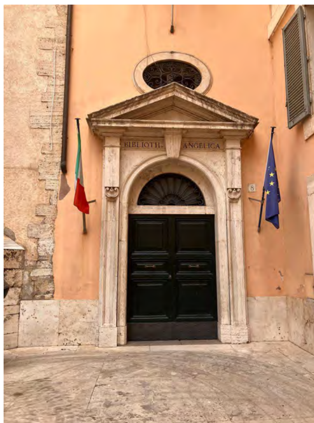
Foto n. 4 – Ingresso principale alla Biblioteca su piazza di Sant'Agostino n.8.
