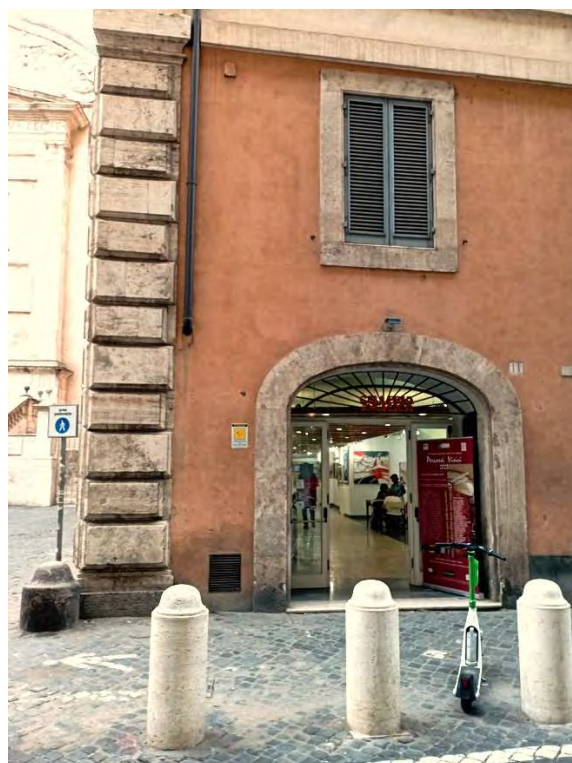
Foto n. 2 – Ingresso della Galleria su via di Sant'Agostino n.11.
