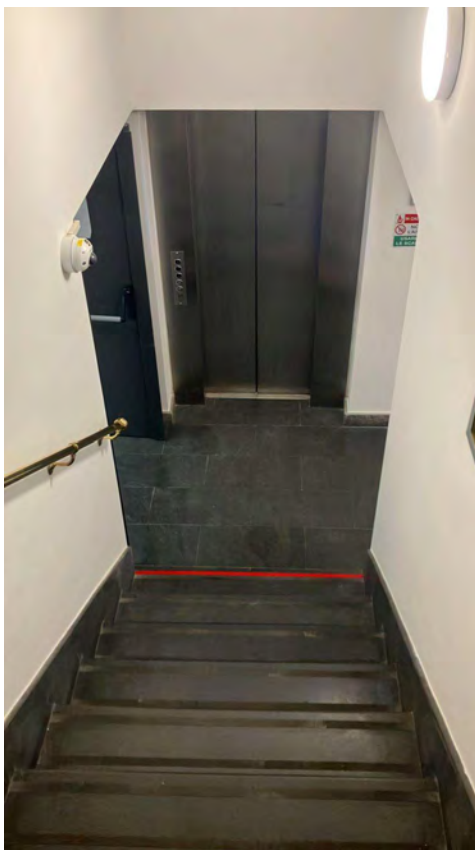
Foto n. 8 – Piano mezzanino, ascensore accessibile.
